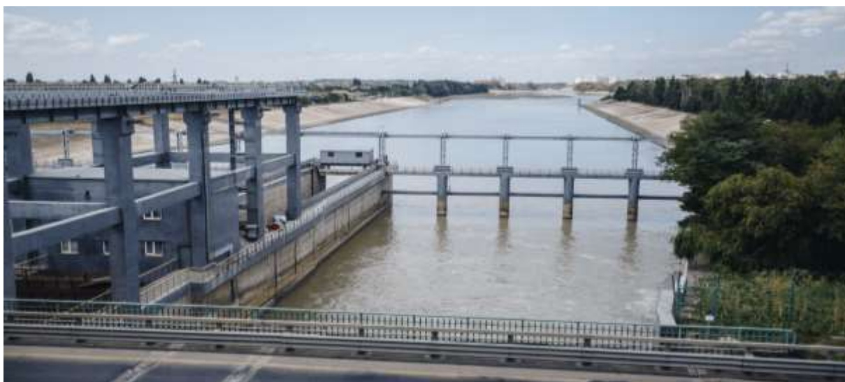
Рисунок 2 – Водозаборные сооружения Краснодарского водохранилища
