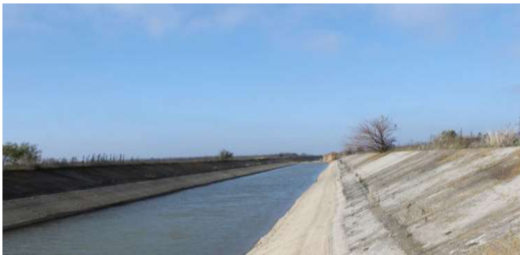
Рисунок 1 – Участок бетонного магистрального канала БСК-4
